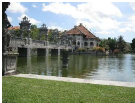
Gambar 3: Jembatan Beton Paviliun (Sumber: Dokumentasi Penulis)
