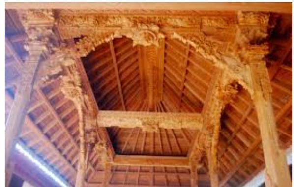
**Gambar 8.** Detail Konstruksi Bale sakenem /Sumanggen bertiang 6
