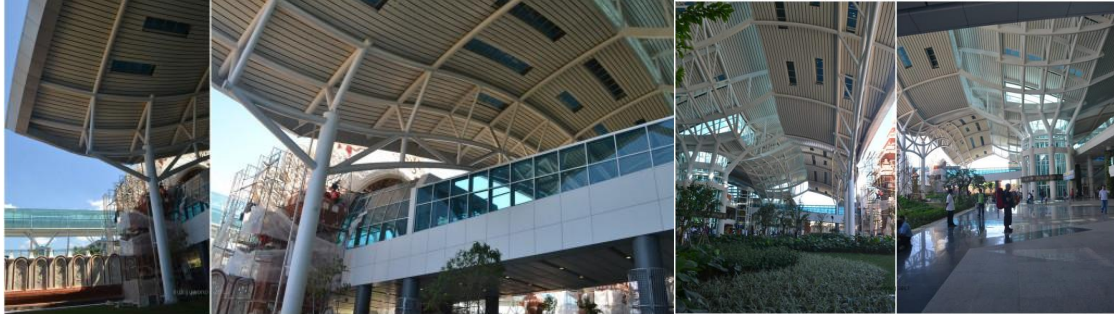
Gambar 8. Atap bandara yang berbentuk melengkung dari bahan besi dan aluminium (Sumber: www.baliairport.com )
