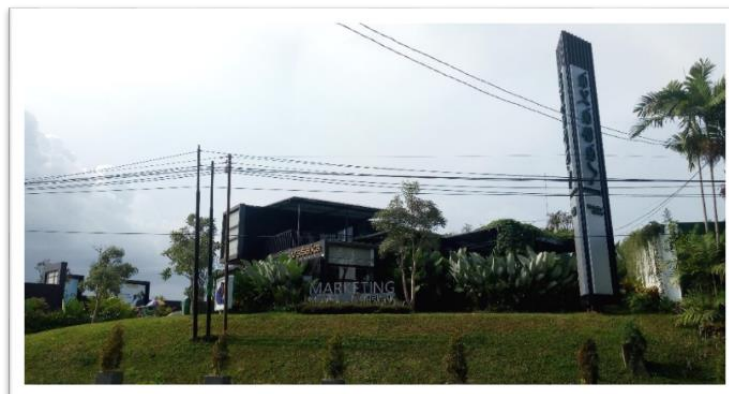
Foto 1. Bangunan Kontainer Kantor Vasaka dari arah jalan.
