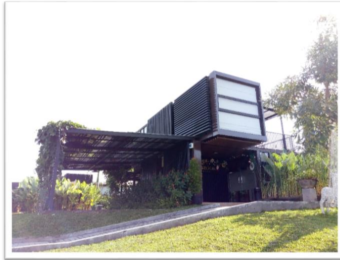
Foto 2. Bangunan Kontainer Kantor Vasaka (Pintu Masuk)
