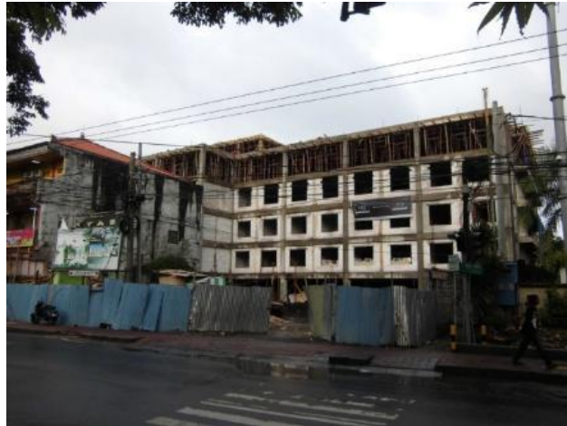
Gambar : Kondisi Area Lantai Atap (Rooftop)
