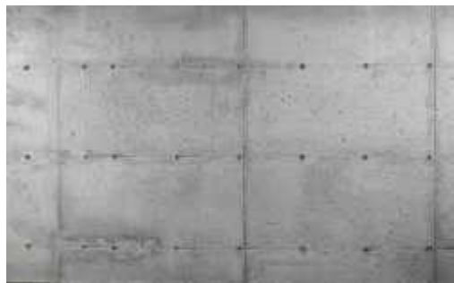
Gambar Plafon expose
