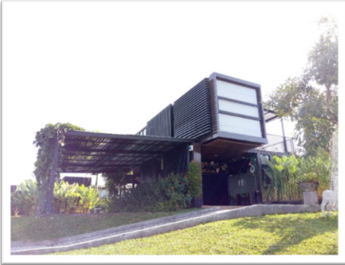
Foto 2. Bangunan Kontainer Kantor Vasaka Pintu Masuk)
