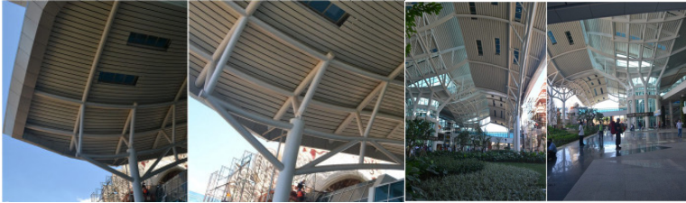
Gambar 8. Atap bandara yang berbentuk melengkung dari bahan besi dan aluminium (Sumber: www.baliairport.com )
