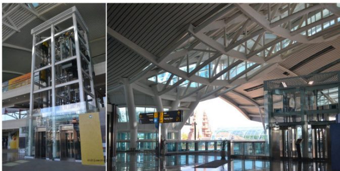
Gambar 10. Penggunaan lift kaca dan baja (Sumber: www.baliairport.com )
