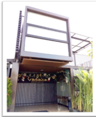
Foto 5. Areal Main Gate Kantor, Bukaan Jendela besar serta pintu utama untuk pencahayaan alami
