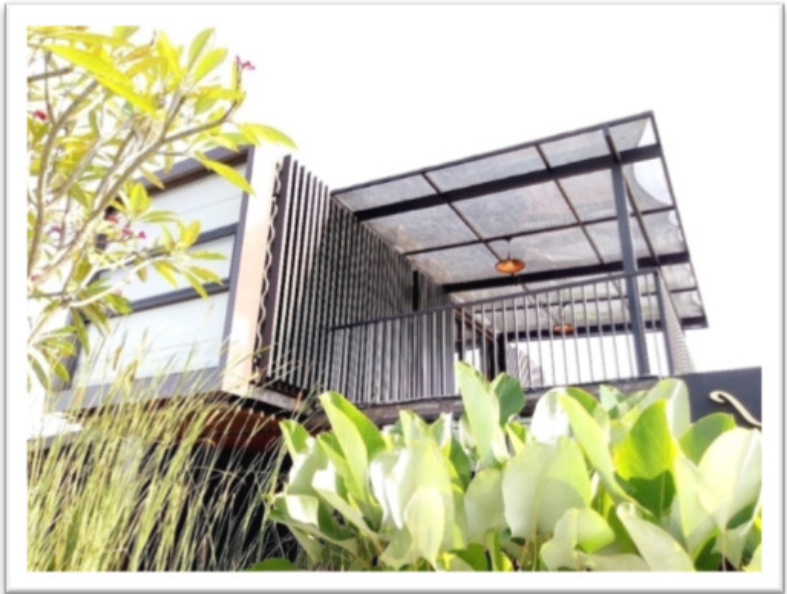
Foto 6. Areal Teras atas beratap Solarlite
