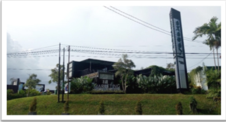
Foto 1. Bangunan Kontainer Kantor Vasaka dari arah jalan.
