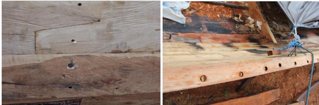
Gambar 5.3 Sistem penyambungan bermakna konsep pola dua
